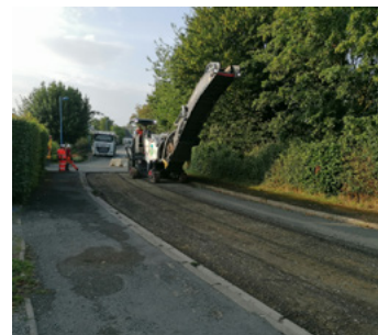
Rabotage de la rue des Chapelles et mise en place de l'enrobé
