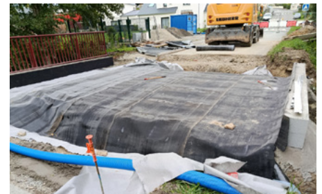
Réfection de l'étanchéité du pont de la Moyette sur la RD 104
