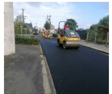
Rabotage de la rue des Chapelles et mise en place de l'enrobé
