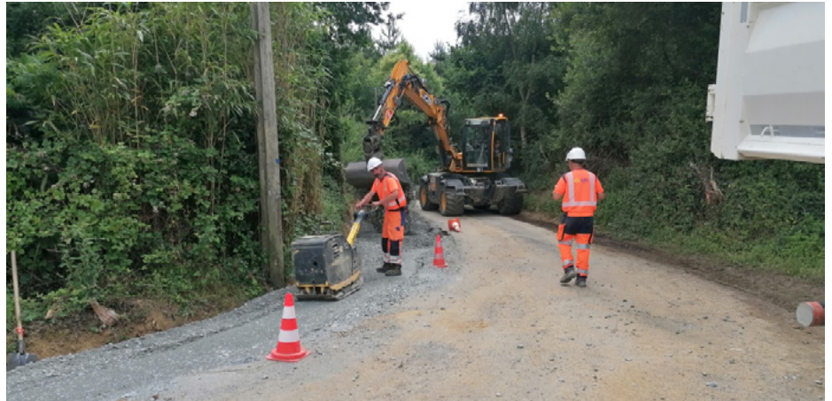
Enfouissement du réseau électrique sur le chemin des Hiaulmes suite à la tempête Ciaran
