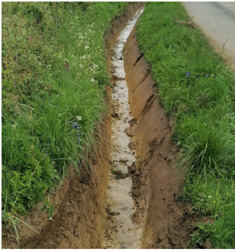
Curage des fossés sur la VC de la Sébourgère
