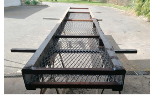
Confection d'une passerelle pour la traversée de la Moyette, en bas du Grand-Pré
