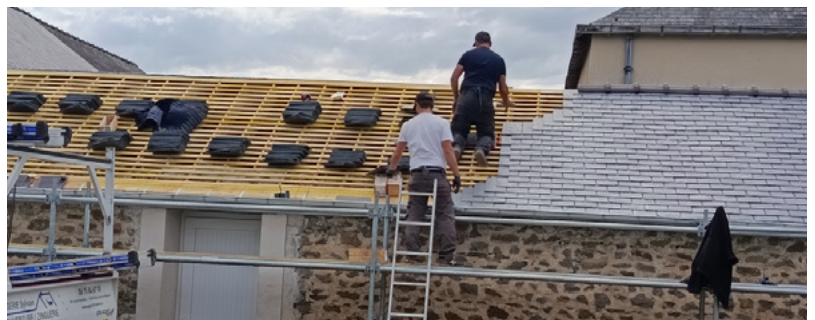
Réfection de la toiture du préau de la salle des fêtes
