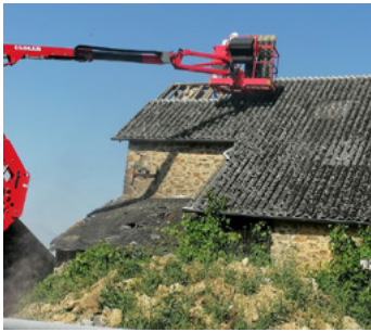
Désamiantage d'un des 3 bâtiments de La Bouilletterie avant démolition
