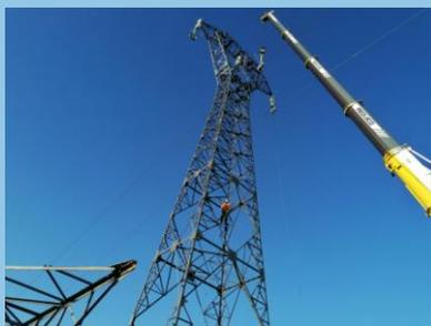
Remplacement de 4 pylônes sur la ligne très haute tension
