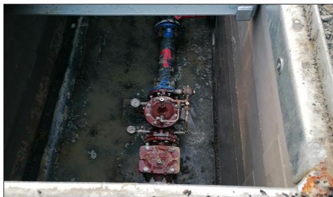
Installation d'un régulateur et d'un réducteur de pression sur le réseau d'eau, rue de Fouilloux.
