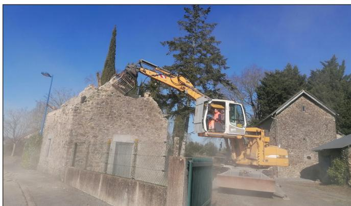
Démolition du fournil à La Bouilletterie dont les pierres ont été utilisées pour la construction du mur de soutènement dans la rue du Ménéil.
