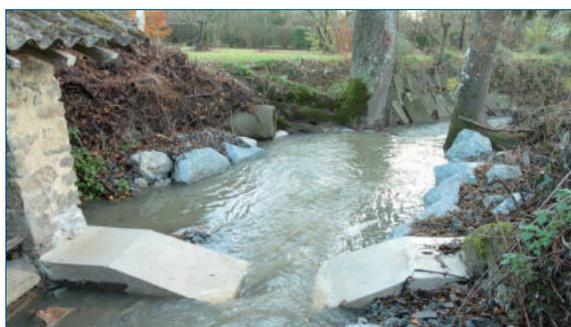
En complément des opérations réalisées en 2020, la recharge en pierre a été mise en place dans le fond du lit et en berge.
