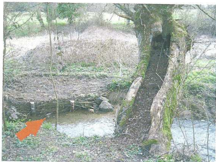
Berge remise en état (treillis en saule)
