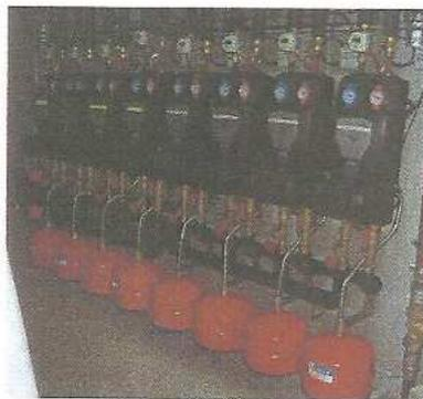
Rappelez-vous, les groupes de froid du boulanger sont connectés sur l'eau de captage. Nous récupérons ainsi les calories rejetées par les groupes frigorifiques au lieu de les jeter dehors, nous les injectons dans la source d'eau de captage, on réchauffe cette boucle et cette chaleur repart dans le chauffage.
